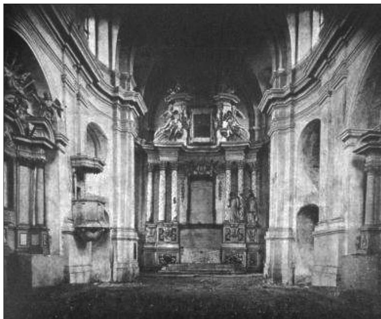
Wnętrze kościoła pofranciszkańskiego w Drohiczynie
